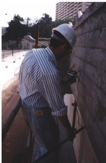
Fig.1 - Medição dos potenciais eléctricos em obra.
